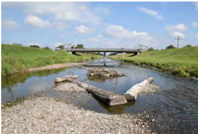
Strömungsenker [RP Freiburg]
