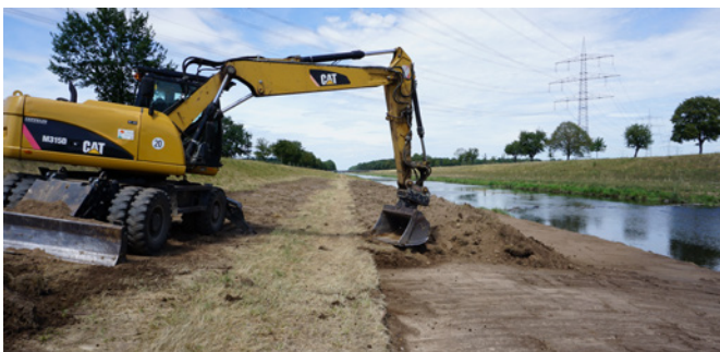
Anschließendes Andecken mit dem Baggerlöffel
