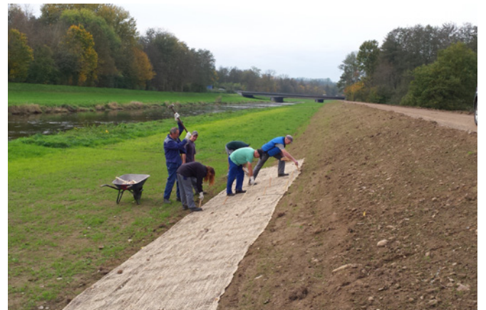
Einbau von Jutegewebe am wasserseitigen Dammfuß nach der Damm- sanierung an der Elz 2015
