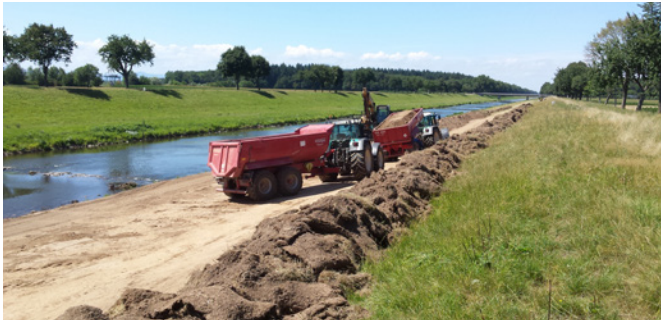
Vorlandabtrag und zwischengelagerte Rasensoden
