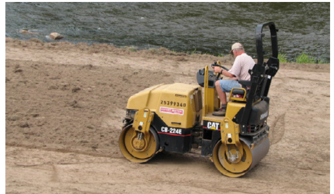
Abwalzen der Vorlandfläche nach der Aussaat am Leopoldskanal 2017
