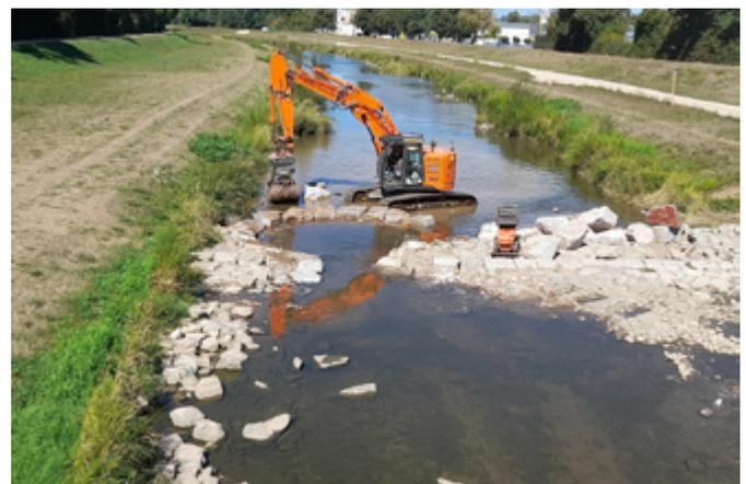
*Teilauflösung Sohlschwelle mit Schneckenbuhne [RP Freiburg]*
