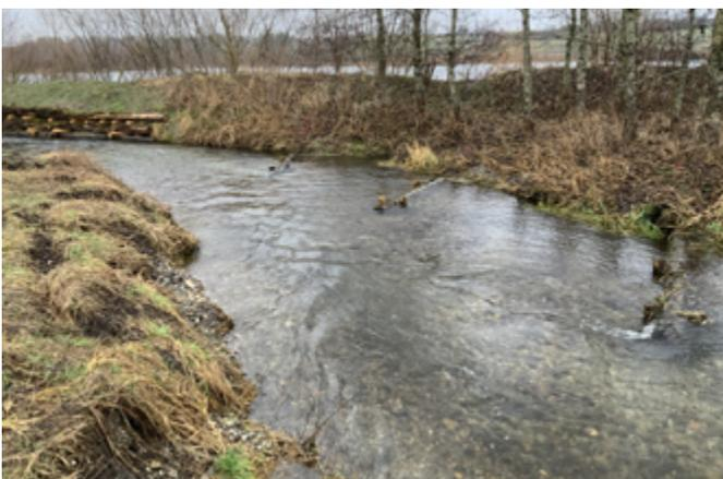
*Ufersicherung durch Buhnen und Krainerwand [LRA Sigmaringen]*
