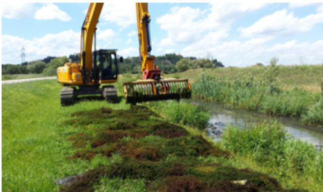
Entnahme der Wasserpest [RP Freiburg]
