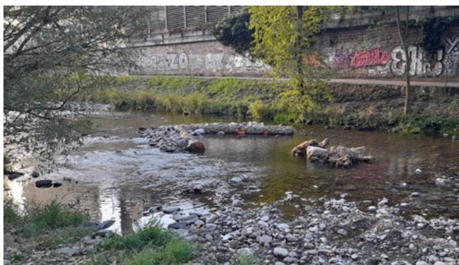
Dreiecksbuhne von Unterstrom [RP Freiburg]
