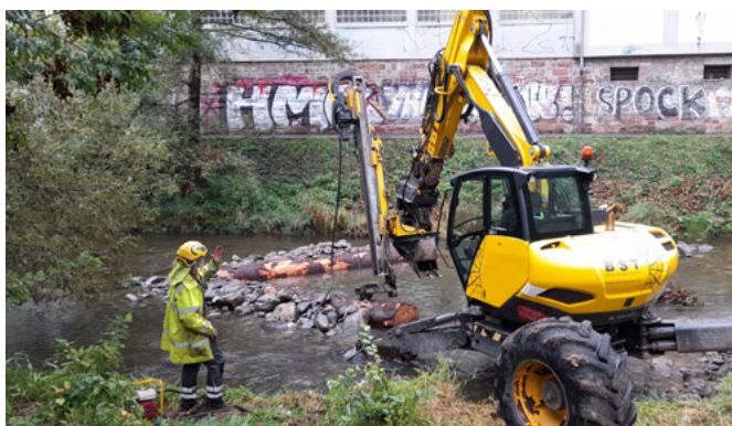
Fixierung mit Stahlankern [RP Freiburg]
