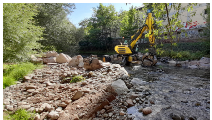
Bau des Strömungstrichters [RP Freiburg]
