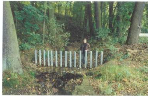
Totholzfangstangen an einem kleinen Fließgewässer ▲ Foto: K. Träbing
