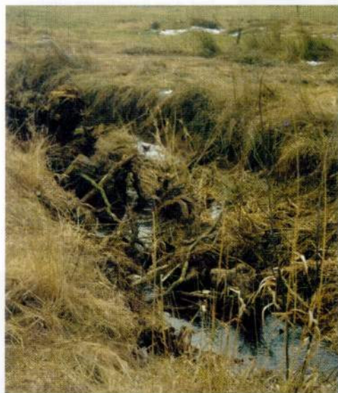
Die auf der Bachsohle fixierten Wurzelstrünke wurden mit drei langen Bäumen beschwert. Das Astwerk dieser Bäume verkeilt sich beim Einbringen, angeschwemmtes Totholz verstärkte später die Verflechtung. In dieser Position, in der das Totholz nicht weiter befestigt wurde, befindet sich die Akkumulation heute, nach über drei Jahren noch immer.
