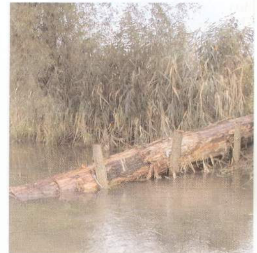
Mit Pfählen und Drahtseilen wird das Aufschwimmen des Stammes verhindert. ▲ Foto: J. Scherle
