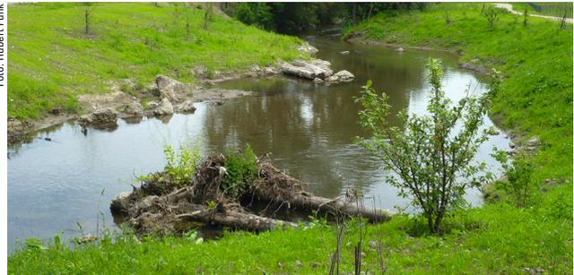
Buhnen, in Fließrichtung eingebracht, bewirken eine Dynamisierung des Gewässerverlaufs.
